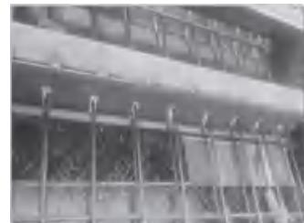
图9 梳形挡板安装
