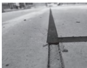
分隔缝清缝、嵌缝图
