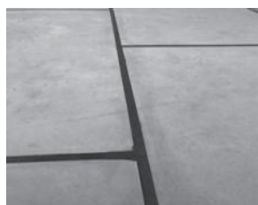
分隔缝清缝、嵌缝图
