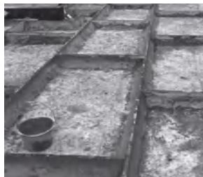
分隔缝嵌塑料线条设置图
