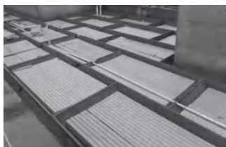
保温板铺设、透气管安装图
