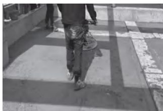
细石混凝土浇筑收面图
