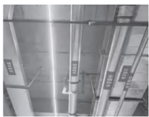
管道安装工艺样板
