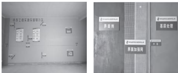
抹灰工程实测实量展示区
