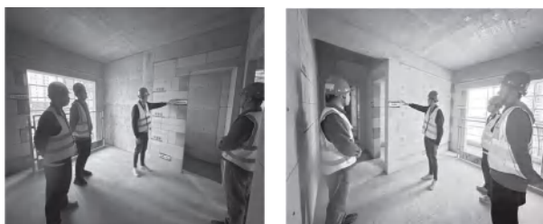
砌筑实测实量展示区
