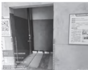
卫生间防水样板
