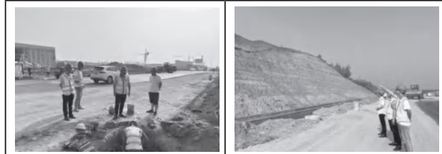
谷城县化工园区基础设施建设一路西延线等道路工程项目开展质量专项检查
