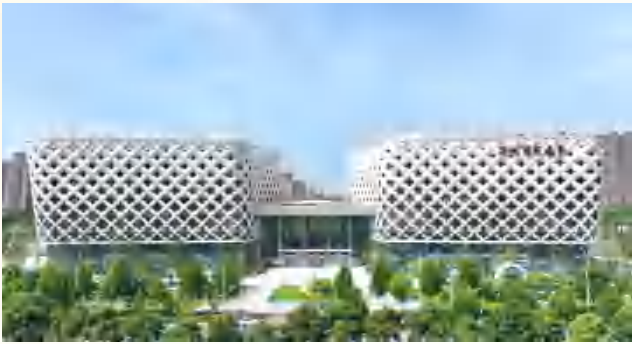
工程名称：荆州市民之家建设项目 施工总承包单位：中建三局第一建设工程有限责任公司
