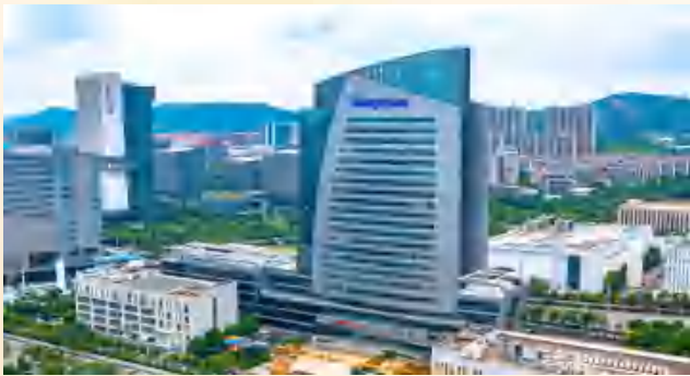
工程名称：大功率光纤激光器及关键器件研发基地（二期）（全部自用） 施工总承包单位：中国建筑第八工程局有限公司
