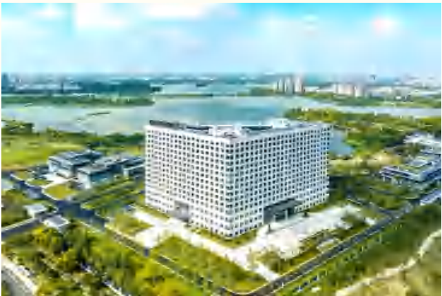
工程名称：调度通信楼 承建单位：中建三局第三建设工程有限责任公司
