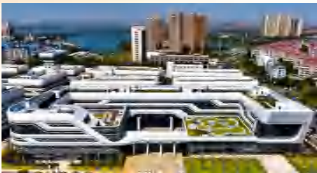
工程名称：武汉开发区人工智能科技园（沌阳街民营科技工业园一区改扩建及产业提升）项目—科技研发楼 施工总承包单位：中国一冶集团有限公司
