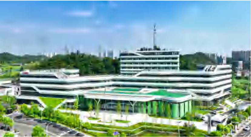
工程名称：宜昌公共卫生中心建设工程项目（主楼、配电室、医疗废弃暂存间及门房） 承建单位：湖北广盛建设集团有限责任公司 中南建筑设计院股份有限公司 博菲特环境科技有限公司
