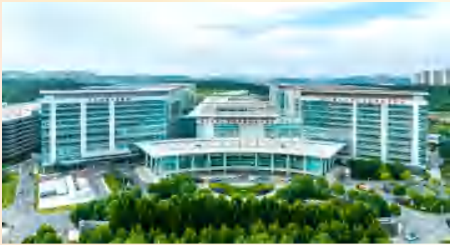
工程名称：华中科技大学同济医院光谷院区儿童医疗中心（光谷同济儿童医院）项目 施工总承包单位：中建三局集团有限公司
