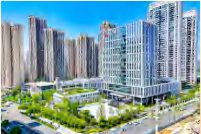
工程名称：新建居住、商务项目(汉阳市政建设大厦)（一标段） 承建单位：武汉博宏建设集团有限公司 武汉市汉阳市政建设集团有限公司
