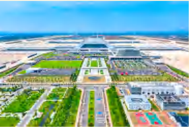
工程名称：新建湖北鄂州民用机场转运中心工程主楼施工总承包工程 承建单位：中天建设集团有限公司
