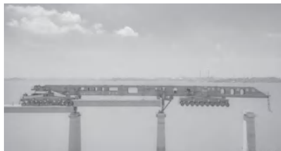
中铁十一局研发的世界首台千吨级运架一体架桥机——“昆仑号”入选央企“十大国之重器”
