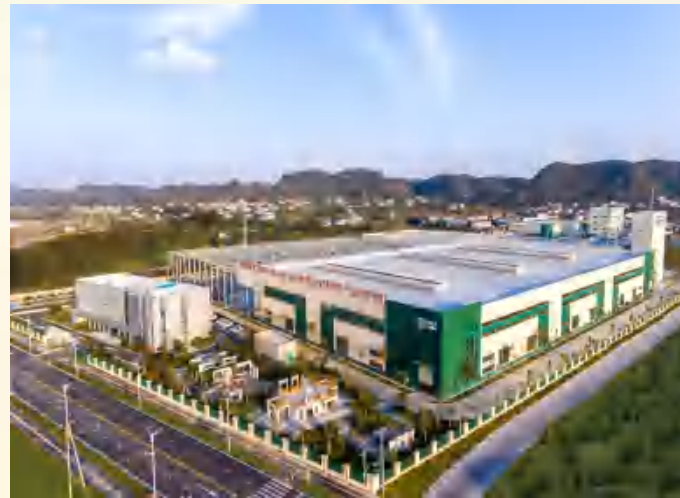
广盛国家装配式建筑产业基地
