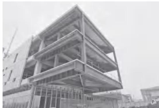
图 1 会议中心主入口悬挑钢结构实景
