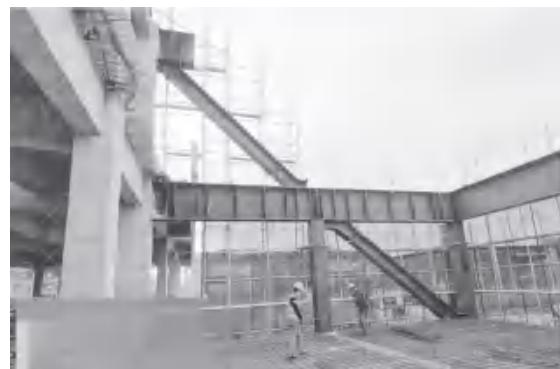
图 11 悬挑钢结构安装立面图
