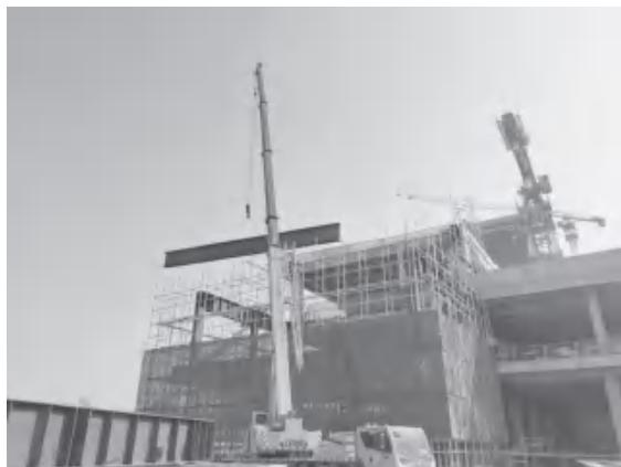
图 10 汽车吊站位及吊装实景图
