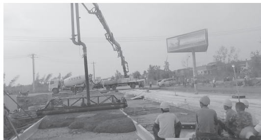
图 2–8 砼面层浇筑施工示意图
