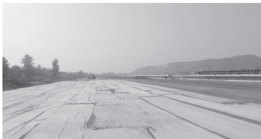
图 2–7 水泥稳定碎石层覆盖养护图
