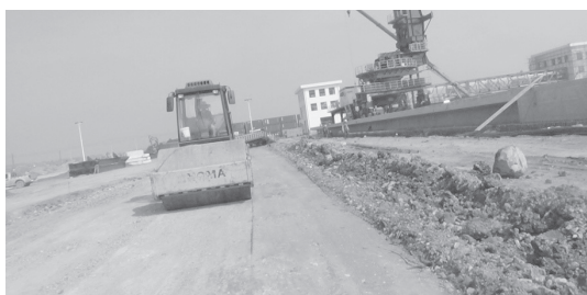
图 2-4 基础整平、碾压压实图
