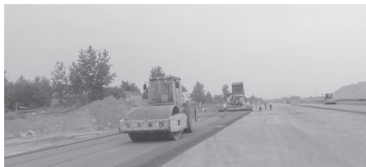
图 2-6 水泥稳定碎石层摊铺、碾压施工图
