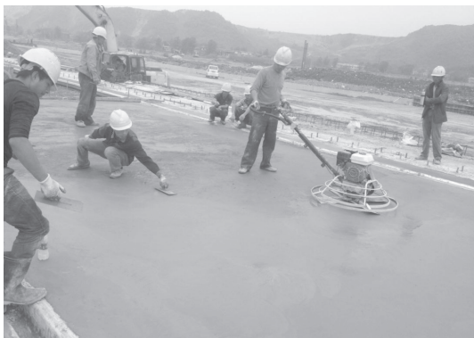
图 2-9 砼面层抹面施工图
