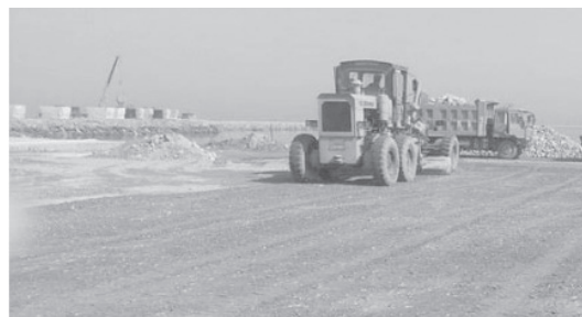
图 2-5 级配碎石平地机整平
