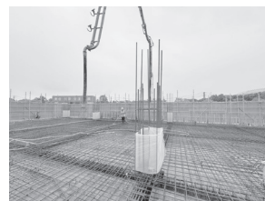
图片 65 湖北工建武汉科技大学人工智能工程实践与创新中心项目混凝土浇筑钢筋防污染措施
