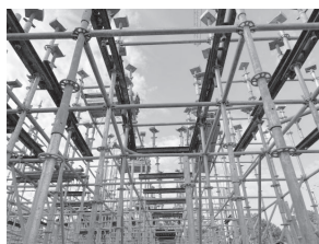
图片 60~61 湖北工建武汉科技大学人工智能工程实践与创新中心项目盘扣式双槽钢托梁模板支撑体系
