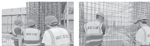
图片 39~40 湖北工建武汉新荣 TOD 天街综合体项目 开展现场质量检查
