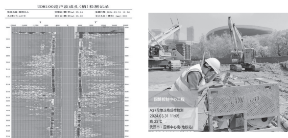
图片 54~55 湖北工建武汉市轨道交通国博控制中心项目地连墙、工程桩采用 UDM 超声波成槽成孔检测
