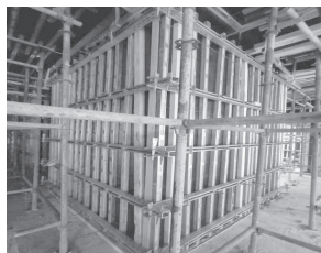
图片 58~59 湖北工建合肥瑶海 YH202301 地块项目模板加固体系采用了钢包木加固体系
