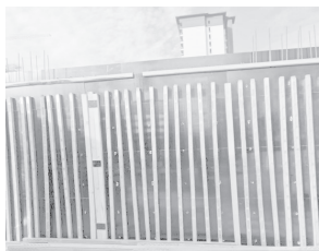
图片 58~59 湖北工建合肥瑶海 YH202301 地块项目模板加固体系采用了钢包木加固体系
