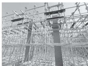
图片 62 湖北工建武汉科技大学人工智能工程实践与创新中心项目钢管约束混凝土柱
