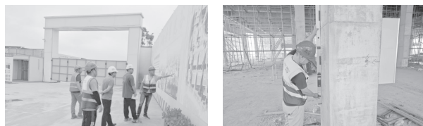
图片 41~42 湖北工建光谷筑芯项目开展现场质量检查
