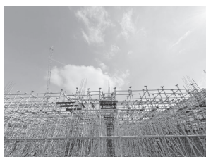
图片 60~61 湖北工建武汉科技大学人工智能工程实践与创新中心项目盘扣式双槽钢托梁模板支撑体系
