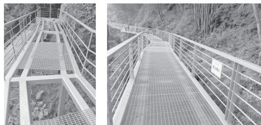
图15 钢结构格栅板安装
