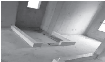
图5.5 建筑后浇坎台成型效果
